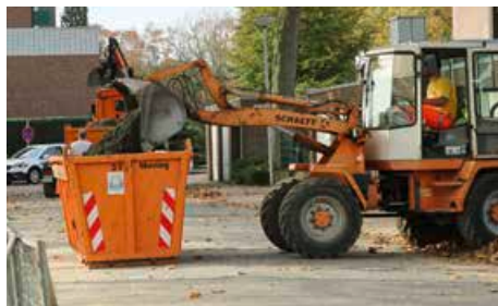
Nicht alle Arbeiten konnten mit schwerem Gerät erledigt werden, dann wurde von Hand geschaufelt.
